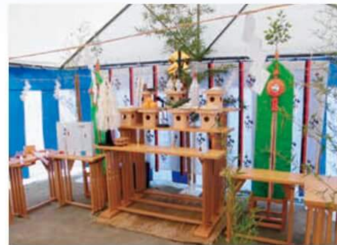
安全祈願祭は、安全避難棟建設場所の施設西側にあった車庫を解体し、桜の木を伐採して更地にした後行われました。
